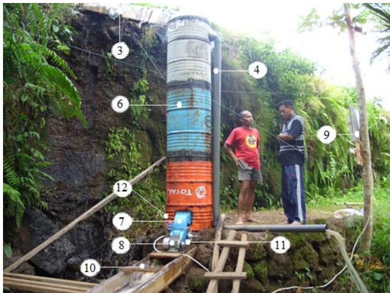
Gambar 10. Sistem pembangkit tenaga piko-hidro model drum di lapangan
