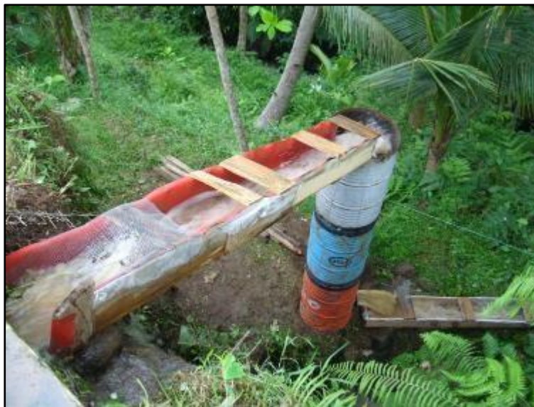
Gambar 3. Saluran Pengantar dan Saluran Buang Saat Terpasang
