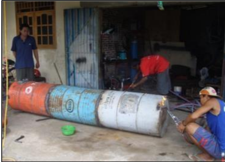
Gambar 2. Perakitan Drum Penampung
