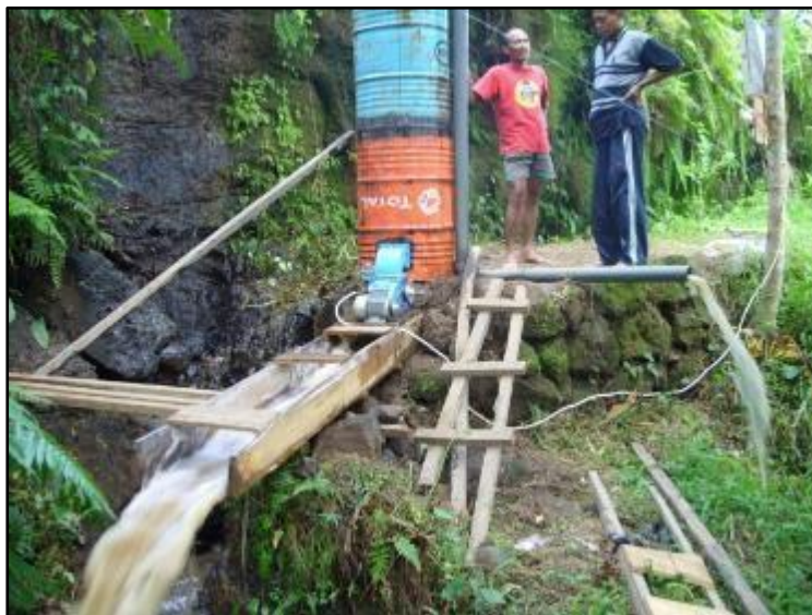
Gambar 9. Posisi Saluran Limbah dan Saluran Buang
