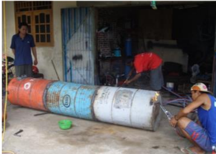
Gambar 2. Perakitan drum penampung
