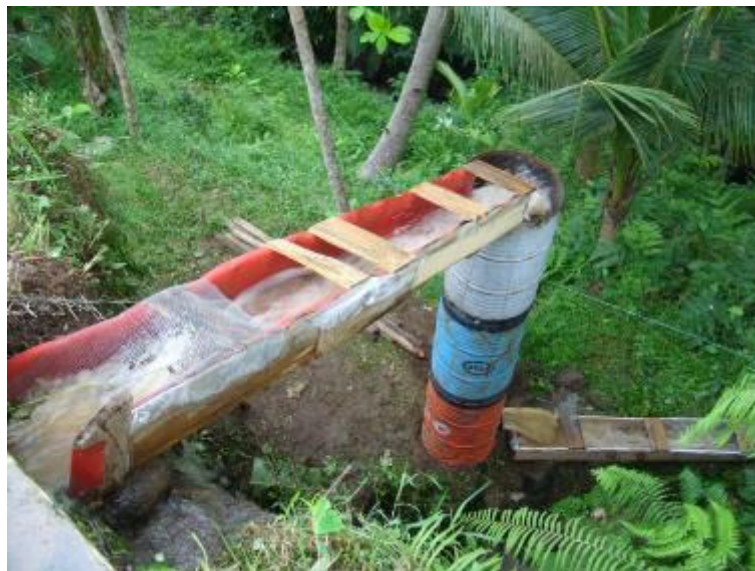
Gambar 3. Saluran pengantar dan saluran buang saat terpasang
