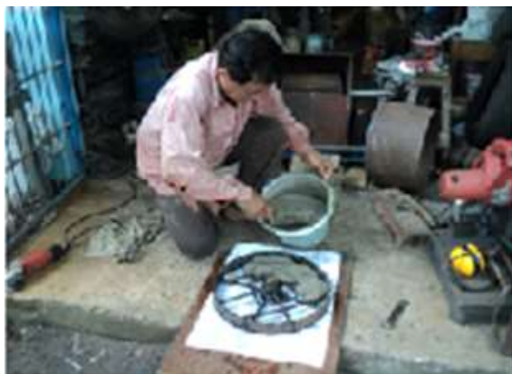
Gambar 10. Pengecoran dg. adonan beton
