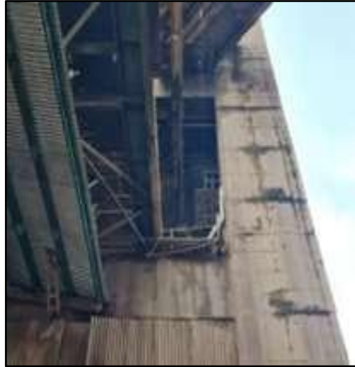
Gambar 12. Tampak jalur area kerja Hoist dari lantai 1.
