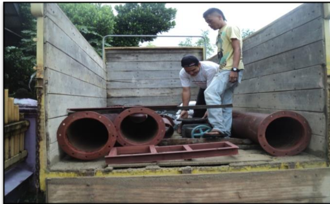
Gambar 12. Pengangkutan Peralatan Mekanik PLTPH Ke Dalam Bak Truk Untuk Dibawa Ke Lokasi Pembangkit Di Solok Selatan Sejauh 150 Km
