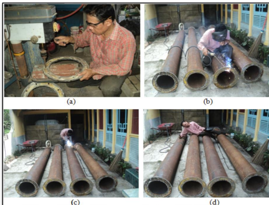
Gambar 7. Pembuatan Lubang Baut Pada Flange Dengan Mesin Bor (a), Penyambungan Flange Pada Pangkal Pipa Pesat (b) Pada Ujung Pipa Pesat (c), dan Hasil Akhir Kedua Ujung Pipa Pesat Telah Dilengkapi Dengan Flange (d)
