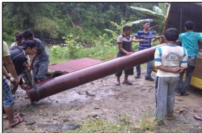
Gambar 16. Pemuda Kampung Mamping Berpartisipasi Aktif Menurunkan Pipa Pesat Dari Bak Truk Di Tengah Guyuran Hujan
