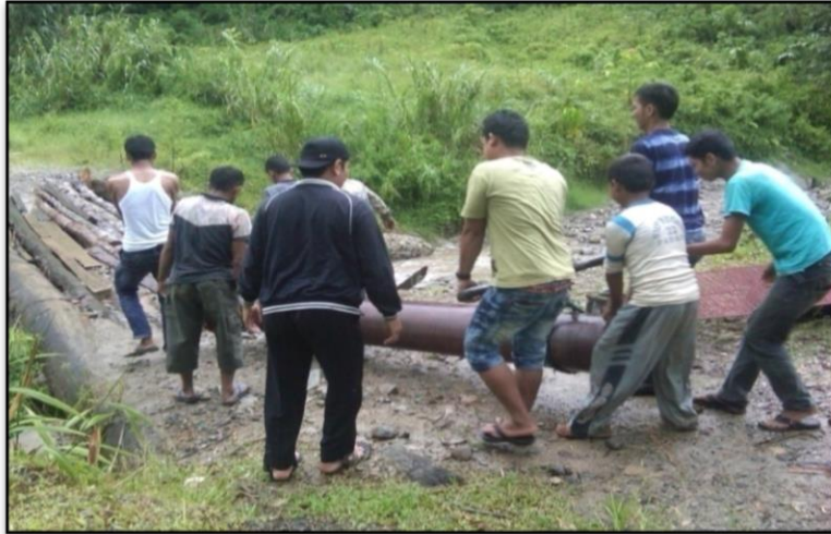
Gambar 17. Pemindahan Pipa Pesat Menyebrangi Sungai Melalui Jembatan Darurat
