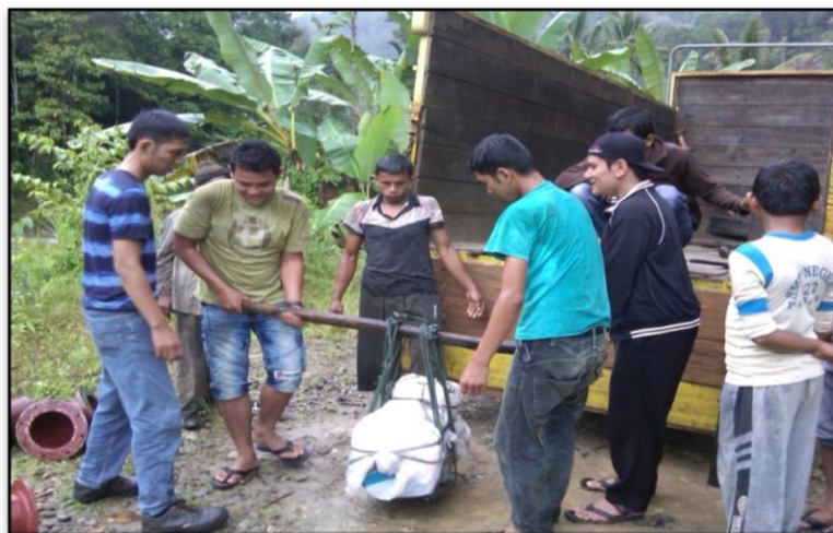
Gambar 18. Pemindahan Generator Yang Dibungkus Terpal Putih Agar Terhindar Dari Risiko Hujan Saat Di Perjalanan
